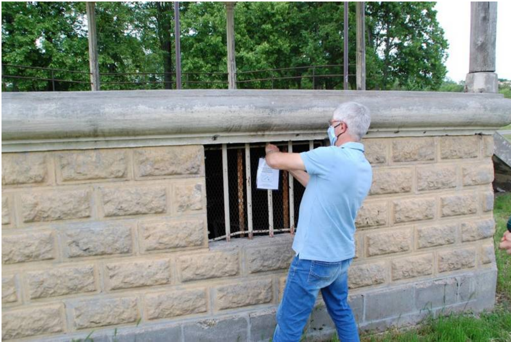
Le placement des balises.
